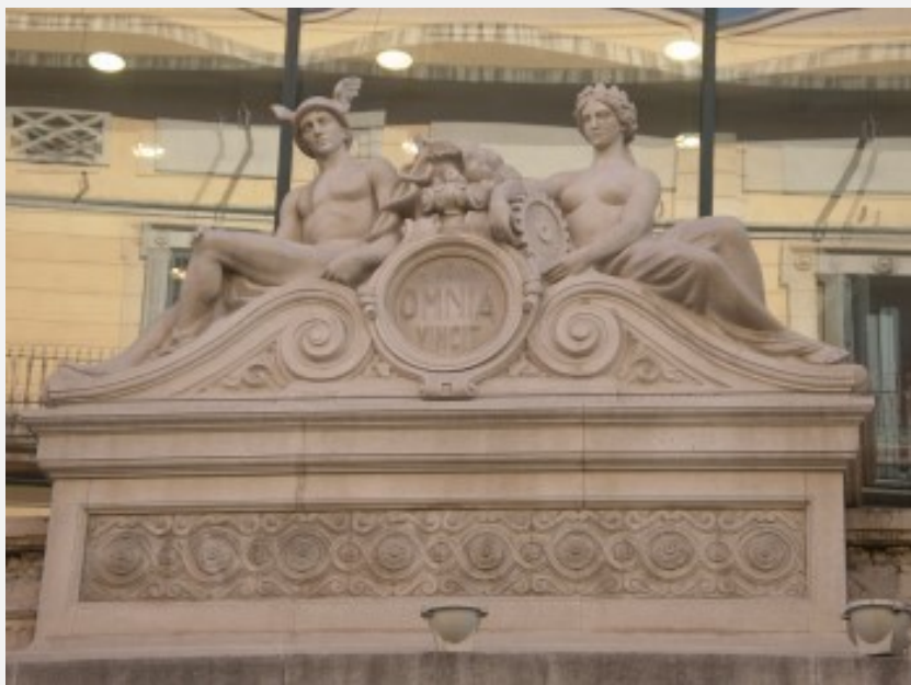
Detalle de la fachada de Almacenes Jorba
