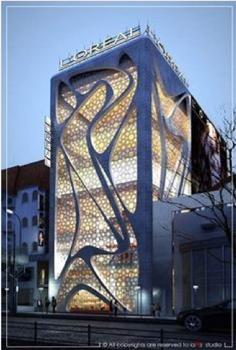
Edificio L'Oréal en Estocolmo
